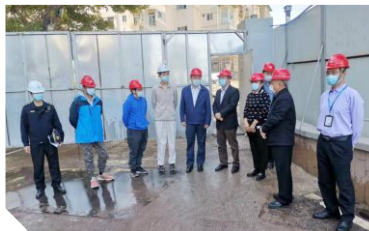
荔湾区常委安建国(左五)一行来我院进行项目施工检查
